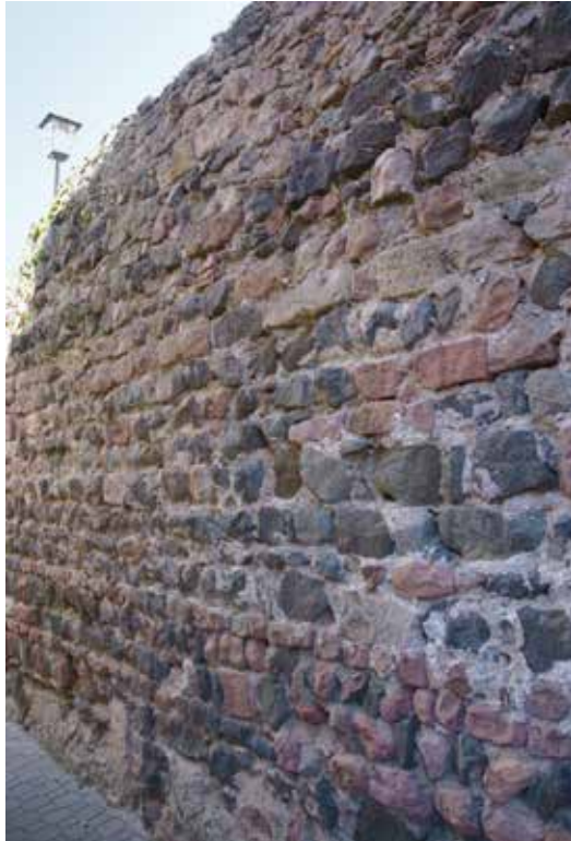
Abb. 8: Großkrotzenburg. Ansicht der Außenschale der Südmauer westlich des Südtors.
