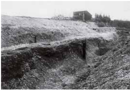
Abb. 2b: Augsburg-Oberhausen, Grabung 1913: Blick auf die doppelte Pfahlreihe mit organischer Füllung dazwischen.
