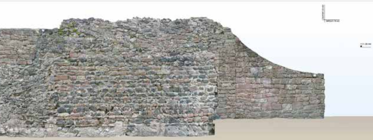
Abb. 9: Großkrotzenburg. Photogrammetrische Dokumentation der Außenschale der Südmauer des Kastells.
