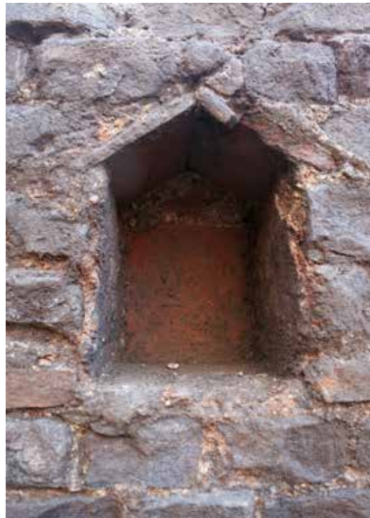
Abb. 5: Bonn, Lagerdorf. Lichtnische im Keller eines Streifenhauses.
