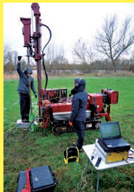
▲ Bohrungen für ein DP EC-Profil. Im Bildhintergrund der Main.
