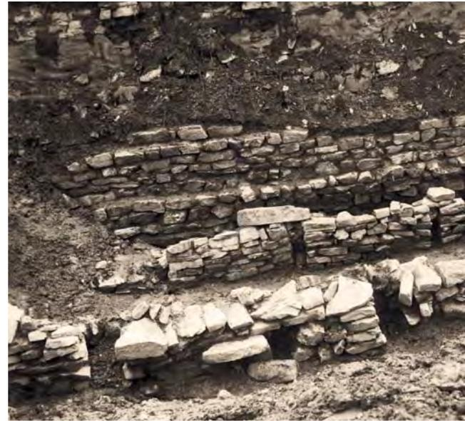
Saalburg. Grabungsfoto der Holz-Stein-Mauer aus dem Jahr 1914. Im Vordergrund liegt die Rampenmauer, dahinter die innere Schale der Holz-Stein-Mauer. Gut zu erkennen sind die Schlitzlöcher, in denen ehemals horizontale Holzbalken lagen.
