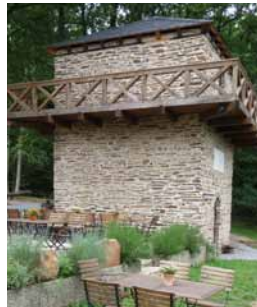
Bad Ems, historischer Wachturmnachbau von 1874 auf dem Wintersberg. Über dem Eingang ist die Marmortafel mit der Bauinschrift zu erkennen.
