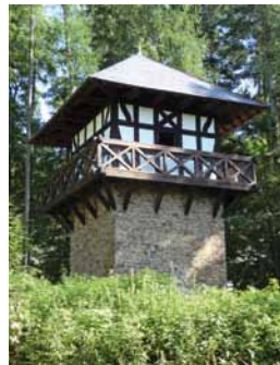
Der Römerturm auf dem Pulverberg in Bendorf-Sayn, errichtet 1912, trägt über einem steinernen Unterbau ein Obergeschoss in Fachwerkbauweise.
