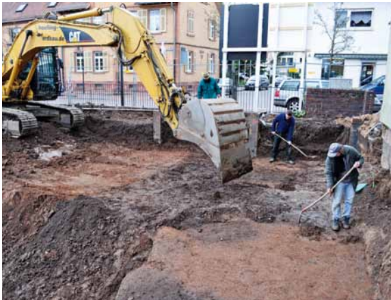
▲ Großkrotzenburg. Situation während der Ausgrabung an der südlichen Flächengrenze. Deutlich ist der tiefe Eingriff durch die Baugrube des Vinzenz-Schwesterhauses am linken Bildrand zu sehen.
