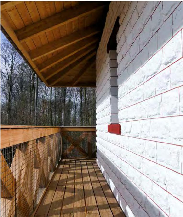
▲ Der balkonartige Umgang aus Holz. Die „Steinmauer“ ist eine in Form gegossene Betonwand, die angedeuteten Handquader sind weiß gefasst und von rotem Fugenstrich gerahmt.
