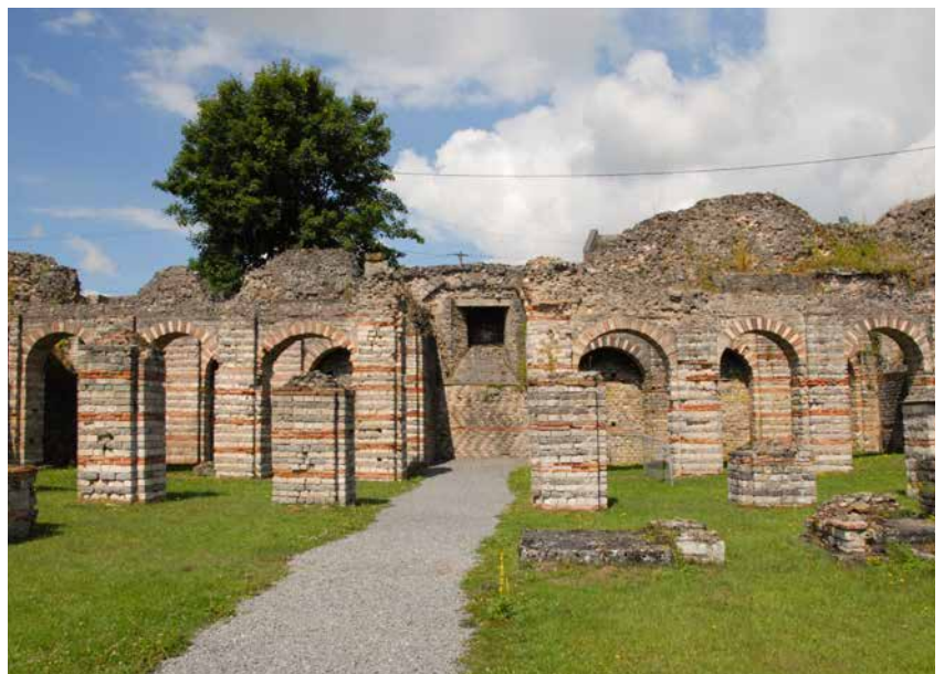
Bavay (Frankreich). Forum der römischen Stadt Bagacum Nerviorum aus dem 2. Jahrhundert n. Chr. mit mehrfarbigem Mauerwerk. In der Bildmitte erkennt man ein Fischgrätmuster wie am Römerturm in Köln.
