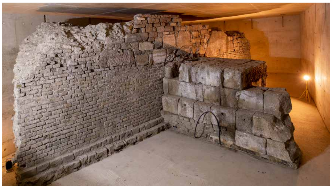
Unterirdischer Besucherraum am Kurt-Hackenbergs-Platz nahe des Römisch-Germanischen Museums der Stadt Köln. Abschnitt der rheinseitigen römischen Stadtmauer mit sekundär zugemauertem Hafentor oberhalb eines Kanalauslasses.
