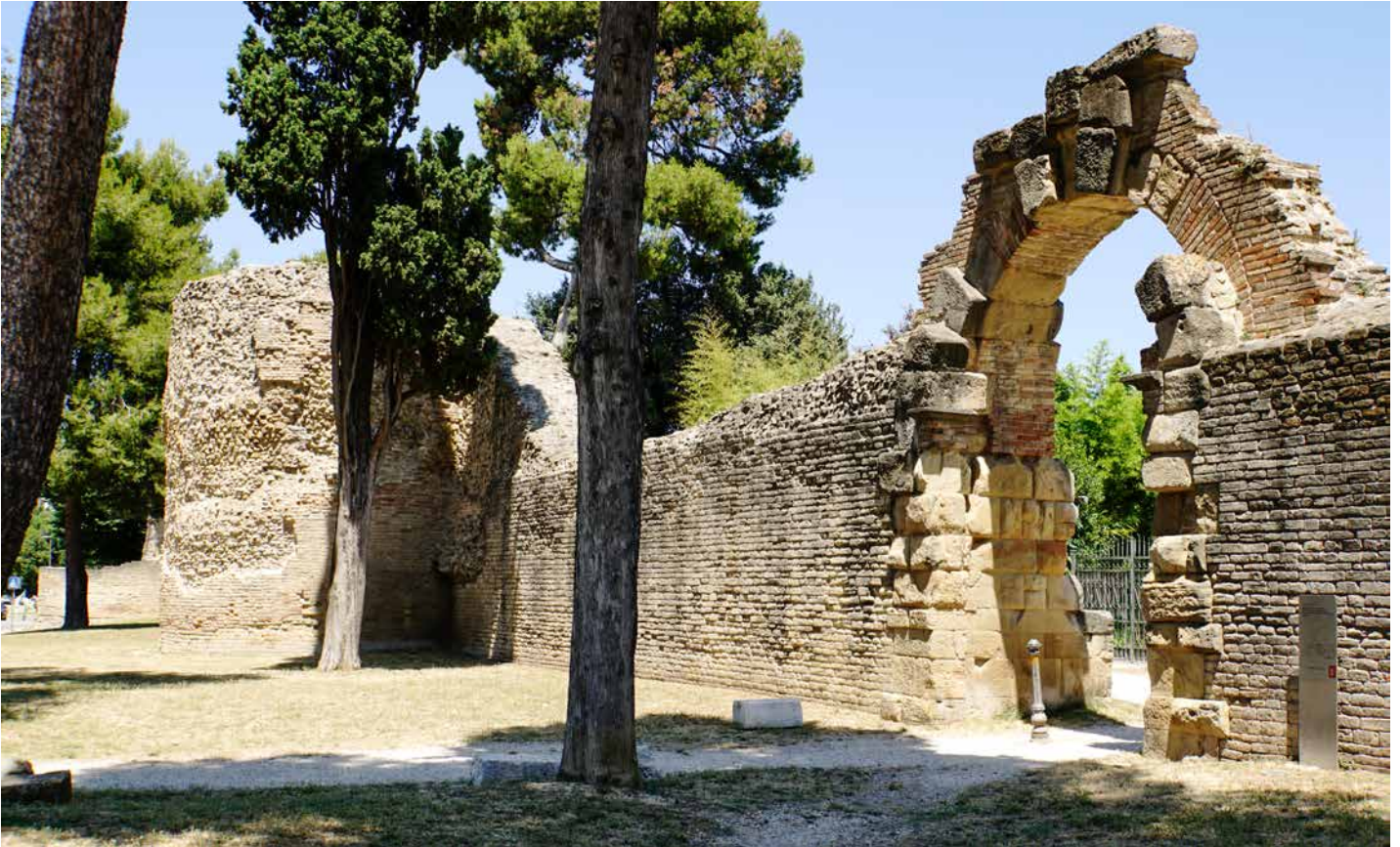
Fano (Italien). Römische Stadtmauer in Fanum Fortunae , gestiftet von Augustus 9 n. Chr., wie eine Bauinschrift mit der lateinischen Formulierung murum dedit dauerhaft bekundet. Im Bildhintergrund ein zylinderförmiger Zwischenturm.
