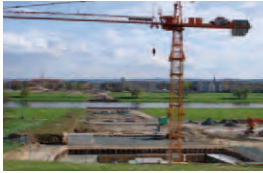
Abb. 5: Bau der Waldschlösschenbrücke in Dresden (April 2009).
