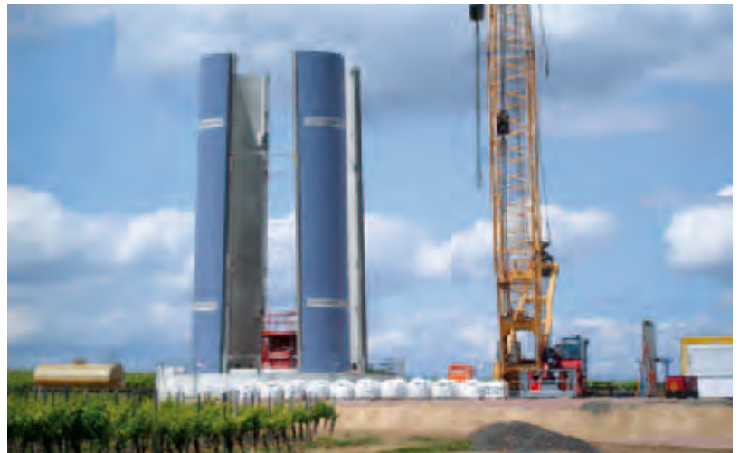
Abb. 12: Errichtung einer Windkraftanlage.
