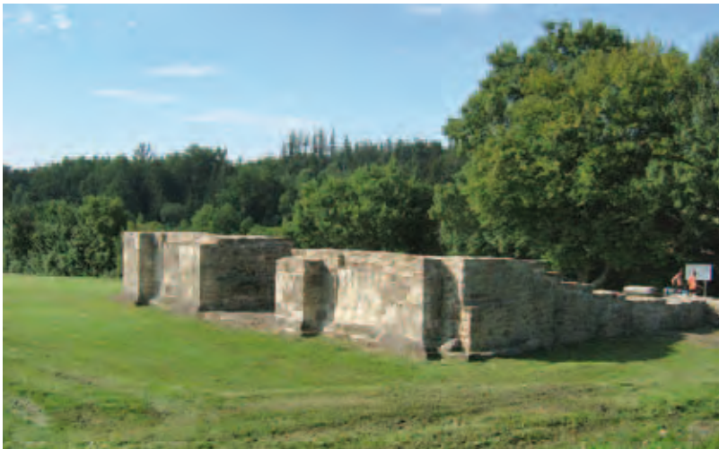
Abb. 13: Das Dalkinger Tor in seinem Zustand bis vor zwei Jahren.
