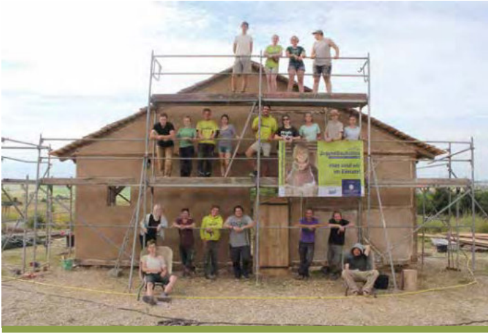
LIMESEUM Ruffenhofen. Beteiligte Jugendliche vor der weitgehend fertiggestellten Hausfassade.
