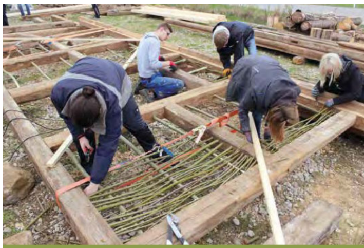
LIMESEUM Ruffenhofen. Hausfassade des Streifenhauses im Bau mit Arbeiten am Flechtwerk.
