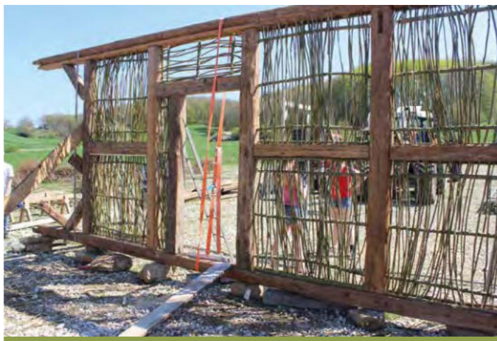
LIMESEUM Ruffenhofen. Aufgerichtete Hausfassade mit Flechtwerk, noch ohne Giebel.
