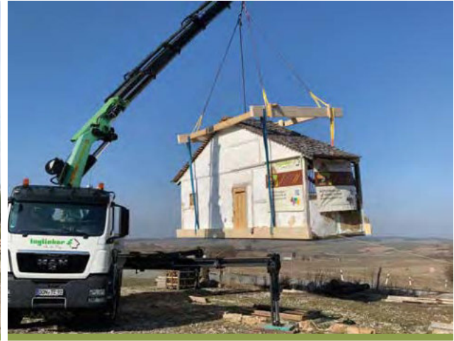
Transport der fertiggestellten Hausfassade zum Gartenschaugelände.
