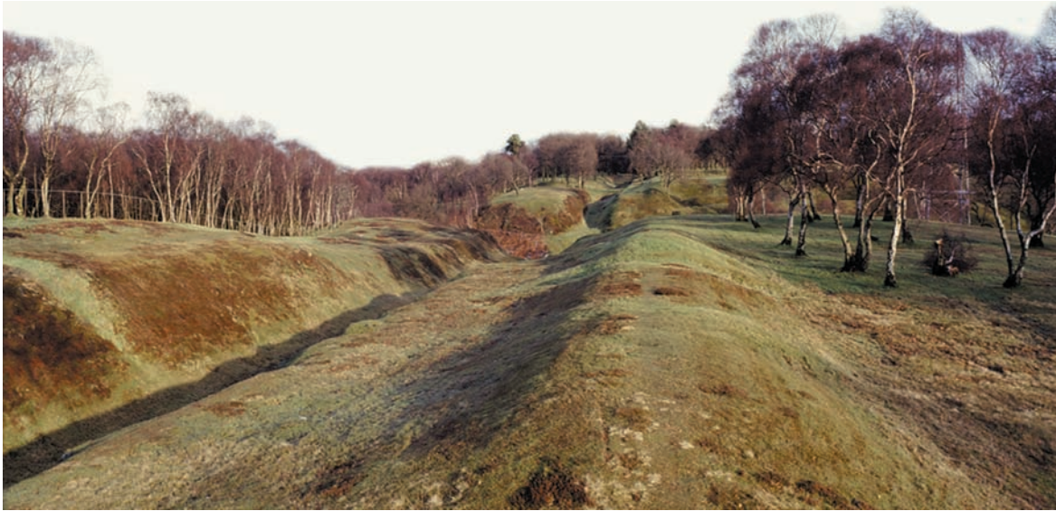
36. The Antonine Wall (Scotland, UK) was built of turf Стената на Анонинус (Шотландия, Великобритания) изградена от торф
