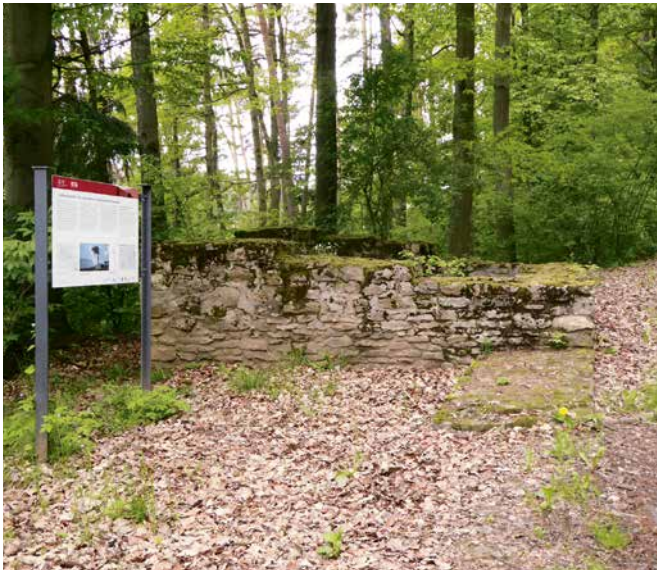
Die konservierten Fundamente der Turmstelle WP 14/20, unmittelbar neben der Straße Dorsbunn-Thannhausen. Andeutungsweise ist auch der Verlauf der direkt an den Turm angrenzenden Limesmauer erkennbar. Details vermittelt eine zweisprachige Informationstafel.
