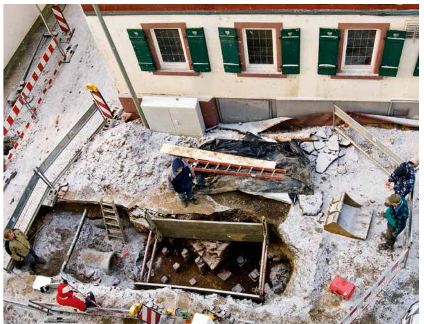
Bad Ems, Rheinland-Pfalz. Untersuchungen am römischen Kastellbad in einer Baumaßnahme im modernen Ortskern.
