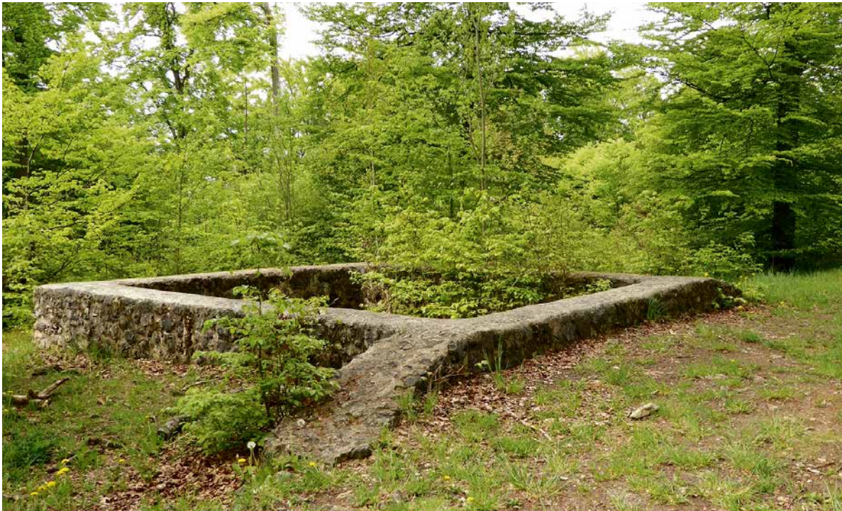
◀ Turmstelle WP 14/78 auf dem Pfahlbuck bei Kipfenberg. Zu sehen sind das konservierte, 5 m × 6 m messende steinerne Fundament und die angebaute Limesmauer.
