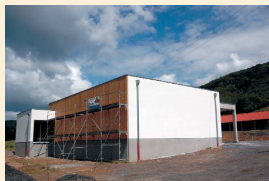
Das Museum kurz vor der Fertigstellung.
