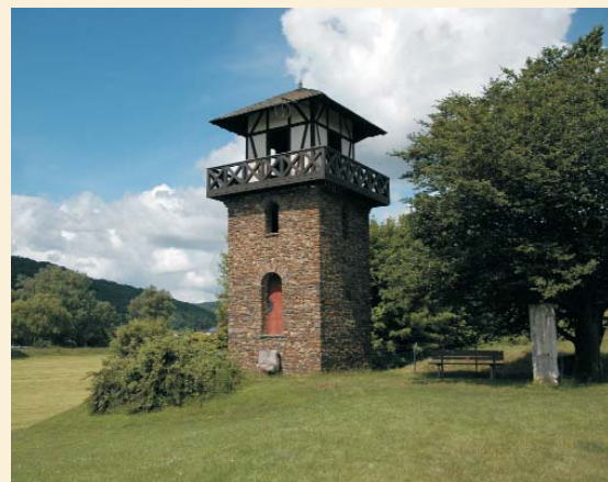
Nachbau des Limesturms WP 1/1.
