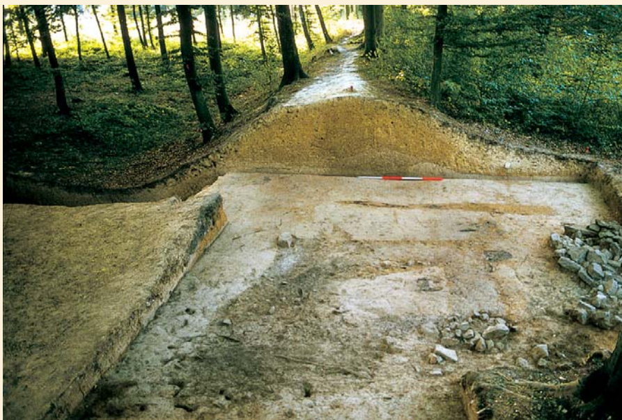
Zweiflingen, Kr. KÜN. Untersuchung des Wachturms 9/23 mit Profil durch Wall und Graben.
