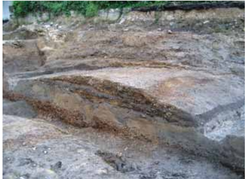
Querschnitt einer römischen Nebenstraße mit Entwässerungsgräben in der südlichen Vorstadt der CCAA. Baugrundvorbereitende Drainagegräben unterhalb des Straßendamms reichen mit ihrer Sohle bis auf den anstehenden Kies.
