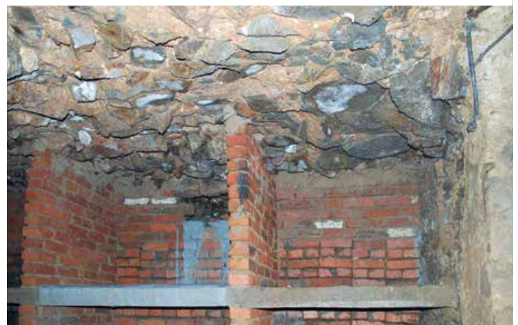
Koblenz. Blick von unten auf die Unterseite des Fundamentes der Wehrmauer, das als Kellerdecke dient.
