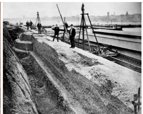
▲ Köln-Deutz. Ausgrabungen 1879–1882 im Kastell Divitia unter Leitung von Oberst F. Wolf. Die Anwesenden stehen auf der Uferschutzmauer, die der zurückgebauten spätrömischen Kastellmauer vorgeblendet ist.
