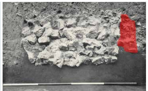
▲ Mainz. Schnitt durch die Wehrmauer des Legionärlagers. Vor das Fundament der älteren Mauer wurde im 4. Jh. eine Front vorgeblendet, um die Mauer zu verstärken (rot markiert).
