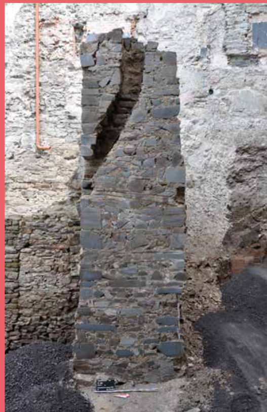
Koblenz. Blick nach Osten: Schnitt durch die Wehrmauer mit dem Drainageschacht.
